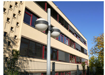
Die Musikschule wurde energetisch saniert
